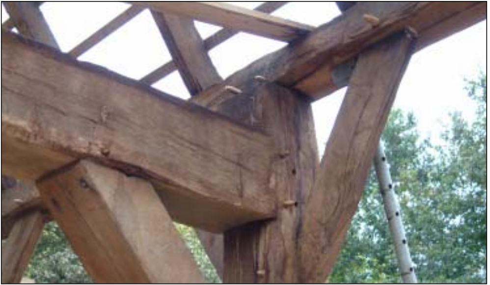
Anderen, NL, Gefügeknoten des Dielenteils um 1600 am Haupthaus des Hofes Speulman
