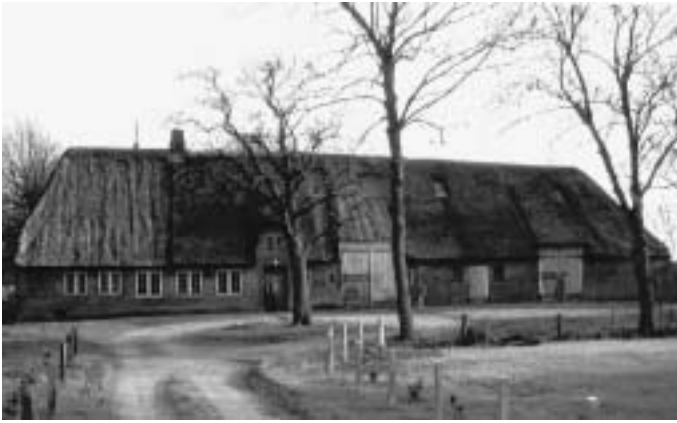
Das Geesthardenhaus ist wie die jütischen Häuser quer geteilt. Haus Sönksen in Borsbüll kurz vor der Umsetzung in das schleswig-holsteinische Freilichtmuseum Molfsee 1974.
