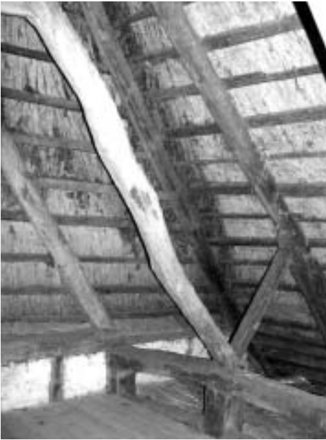
Abb. 2 Die Ständer stoßen durch die Decke in den Dachraum und bilden einen Drempel. Der Längsbalken markiert die ursprüngliche Außenwand. 1699 wurde das Haus seitlich erweitert; rechts die Sparren nach der Erweiterung. Foto: Preßler
