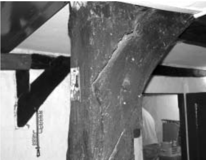
Abb. 4 Die südlichen Ständer stehen seit der Erweiterung im Raum. Die Anblattung des Kopfbandes ist ein Hinweis auf die frühe Erbauungszeit. Das Haus wurde jetzt datiert auf das Jahr 1523. Foto: Preßler
