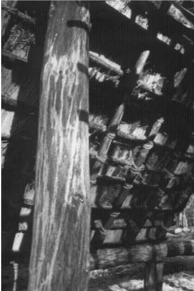
Abb. 4 Die Unterdachkonstruktion des nachgebauten Steinzeithauses von Flögeln (Foto: Verfasser)
