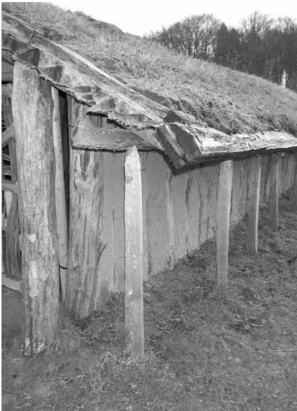
Abb. 7 Detail der Dachkonstruktion des Hauses von Pennigbüttel mit Spaltbohlen und Grassodeneindeckung (Foto: Verfasser)
