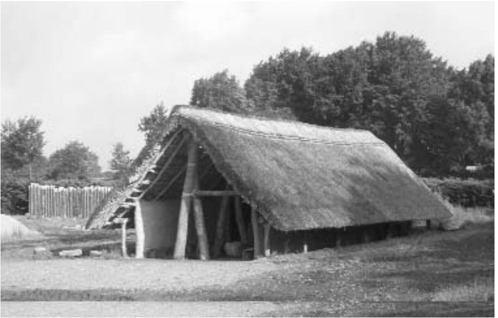
Abb. 3 Modellnachbau des Steinzeithauses von Flögeln mit A-Pfostenkonstruktion (Foto: Verfasser)
