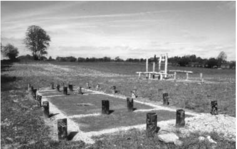
Abb. 1 Die ersten Teilrekonstruktionen auf dem AÖZA-Gelände. Im Vordergrund die Darstellung des Grabungsbefundes von Flügeln mit Holzpfosten, rechts dahinter das „Versuchshaus“. Im Hintergrund ist ein Grabhügel aus der älteren Bronzezeit zu sehen (Foto: Verfasser).
