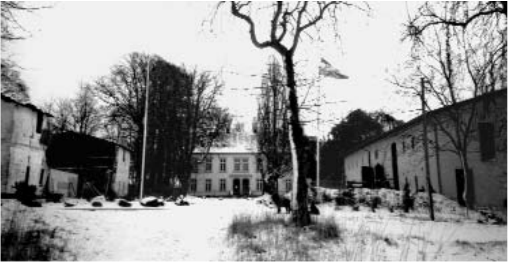
Abb. 1 Wittkielhof, links die baufällige Scheune. Fotos Berndt Lassen
